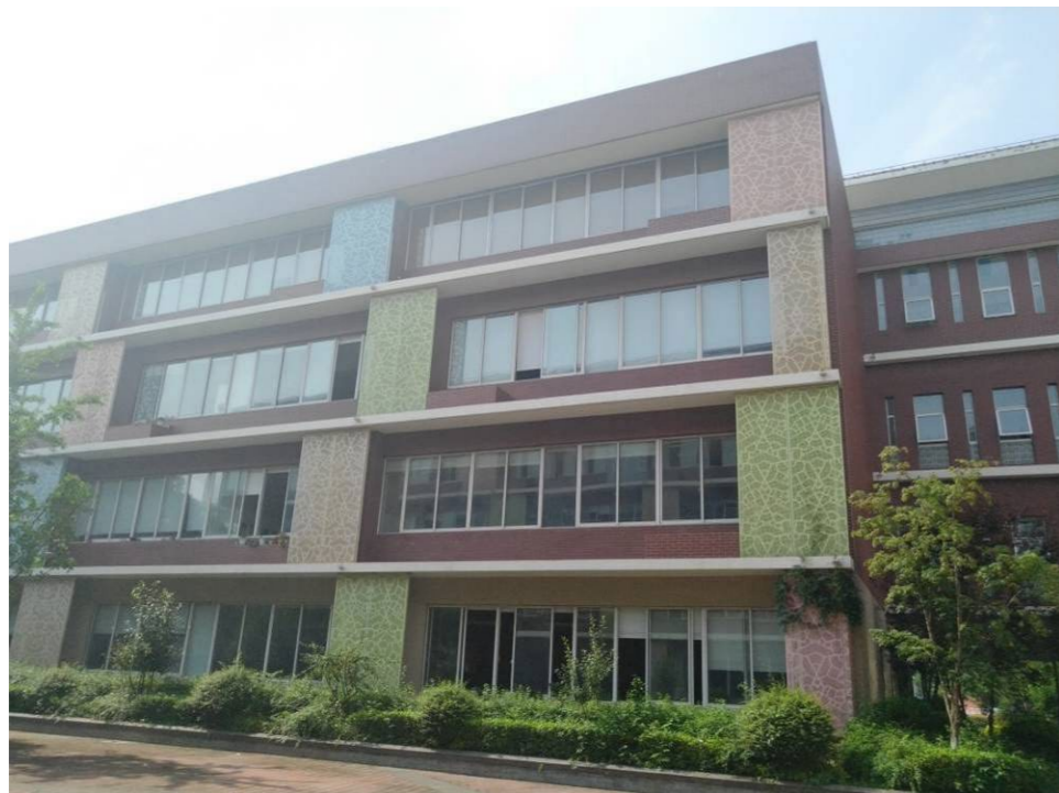
苏州工业园区金鸡湖学校教学区实验楼（西区）外立面
