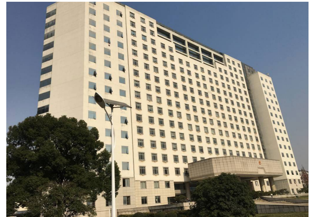
建筑物外立面现状
