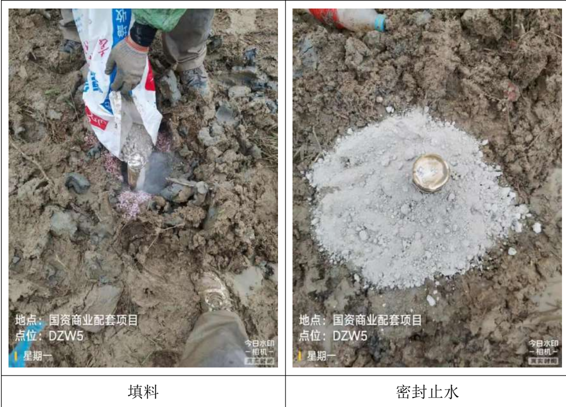
图 4-5 地下水监测井建井过程示例
